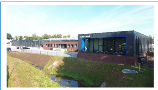
Auch die Außenanlagen inklusive eines Regenrückhaltebeckens vor dem Bildungszentrum, das als Energieeffizienzgebäude gebaut wurde, wurden neu angelegt. (Foto: Mathies Könenkamp)
