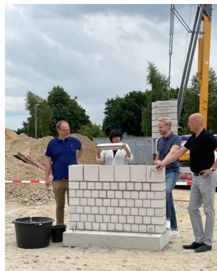
Delme-Geschäftsführerin Nahid Chirazi beim gemeinsamen Einmauern einer Zeitkapsel mit den Vermietern Lars Eickhoff (links) und Jens Köenkamp (ganz rechts) zusammen mit Architekt Mathies Köenkamp.
